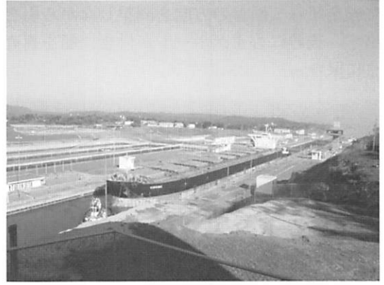
完全に浮き上がってガトゥン湖と同じレベルの水位に達した。
