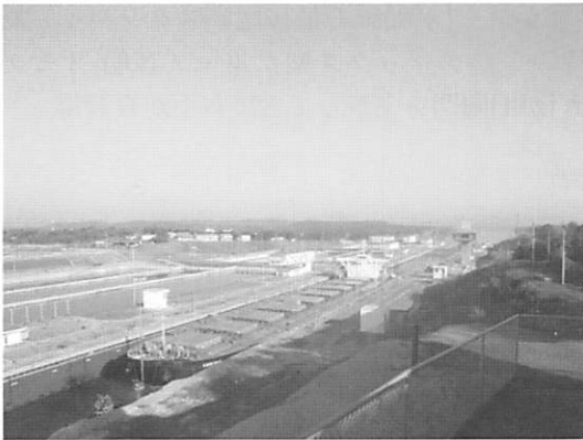
ガトゥンロックの新閘門には商船三井のばら積み船「コルジェ」が入っていた。旧閘門は2列だが、新閘門は1列のみ。左の水面は調整池で、1回に流出する水を60%も減らすために新設された。
